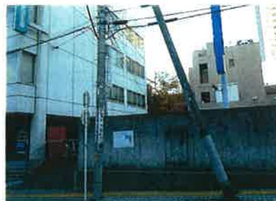
写真左） 北側壁面、歩行者通路沿い
